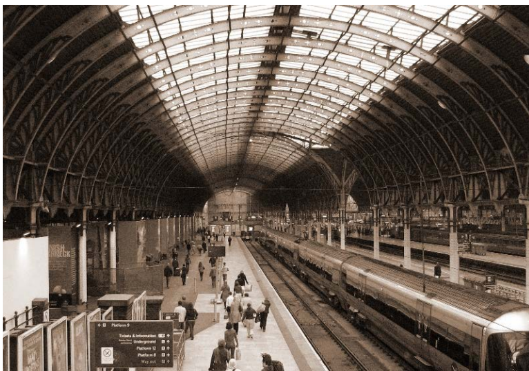
Stazione di Londra (Paddington Station)
