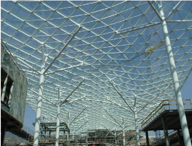
Copertura reticolare: struttura in acciaio e vetro
