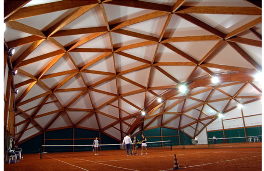
Copertura reticolare: struttura in legno lamellare
